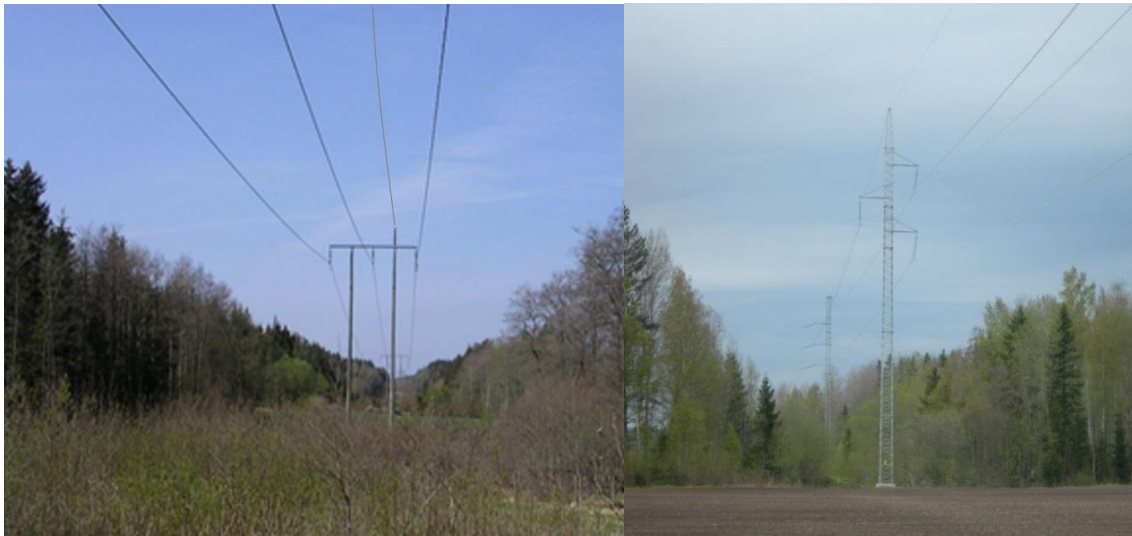
Figur 3. Till vänster exempel på en portalstolpe med topplina. Till höger exempel på en gitterstolpe.
